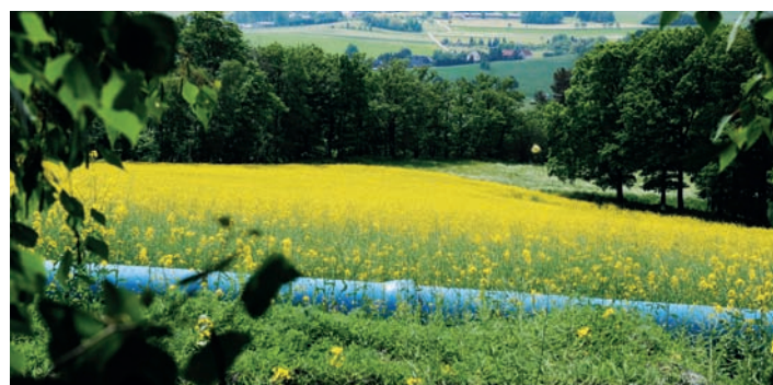
Fliegende Leitung mit BLS®-Verbindungen
