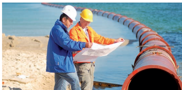
Einschwimmen einer duktilen Gussrohrleitung
